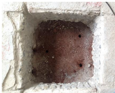
(a) Corte no piso e furos no solo
