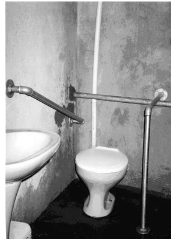
Figura 6: Foto interna do banheiro com barras Fonte: Vizioli, 2003
