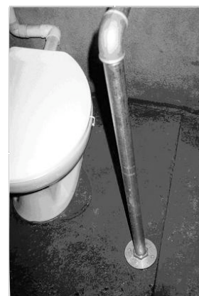
Figura 8: Foto interna do banheiro com barra Fonte: Vizioli, 2003
