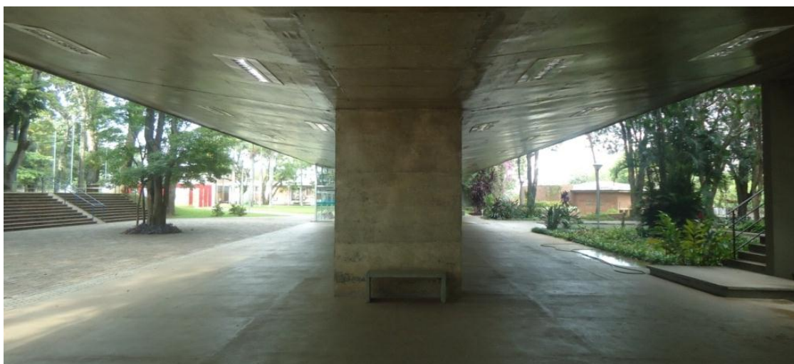
Figura 18 – Pilar do Edifício E1
