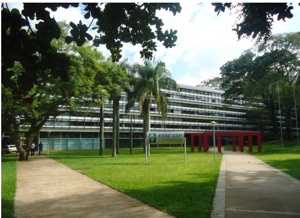
Figura 4 – O Edifício E1
