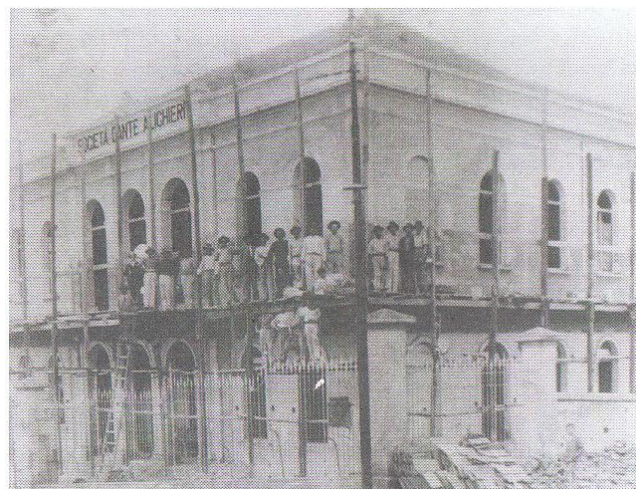
Figura 2 – Casa D’Itália – construção do segundo pavimento
