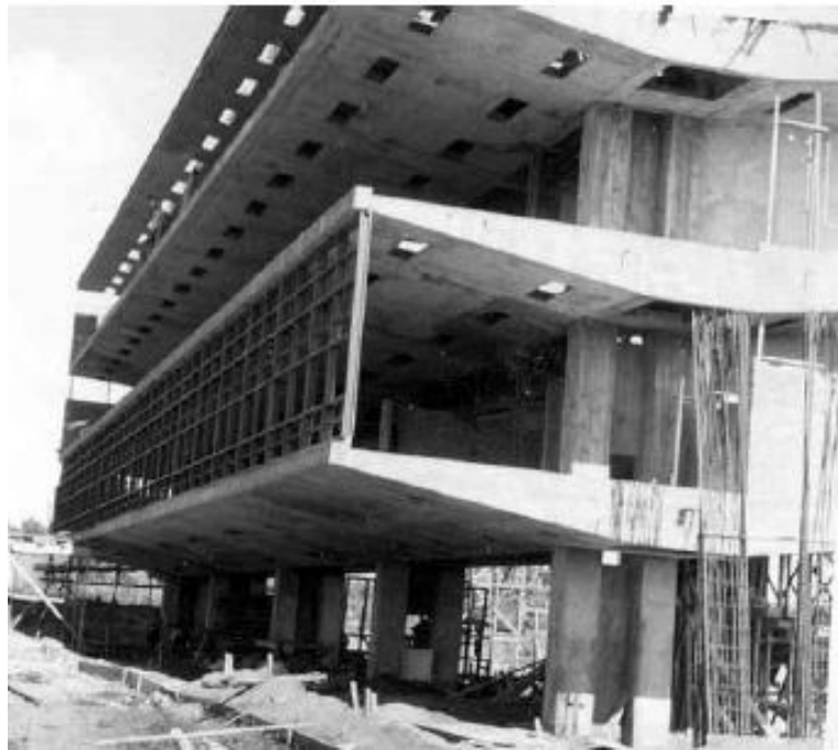
Figura 9 – Construção do Edifício E1 Fonte: VIEIRA, 2008, p.69
