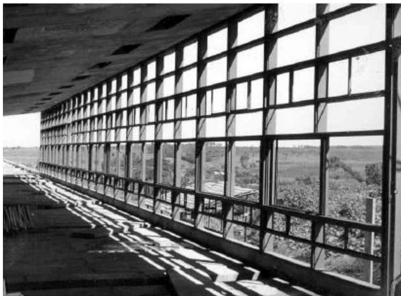
Figura 10 – Construção do Edifício E1 Fonte: VIEIRA, 2008, p.69
