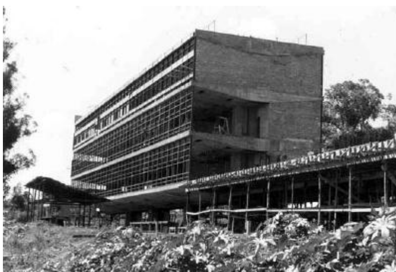
Figura 8 – Construção do Edifício E1
