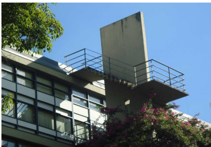
Figura 11 – Escada externa do Edifício E1
