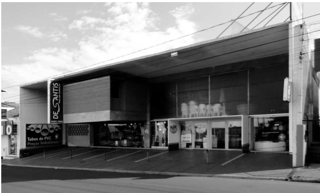
Figura 1: edifício da Comercial de Santis (Foto: Renata Cecilia Gonçalves)
