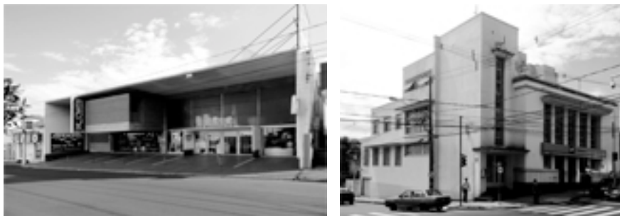
Figuras 1 e 2: os edifícios Comercial de Santis e Sede dos Correios, respectivamente (fotos: Renata C. Gonçalves)
