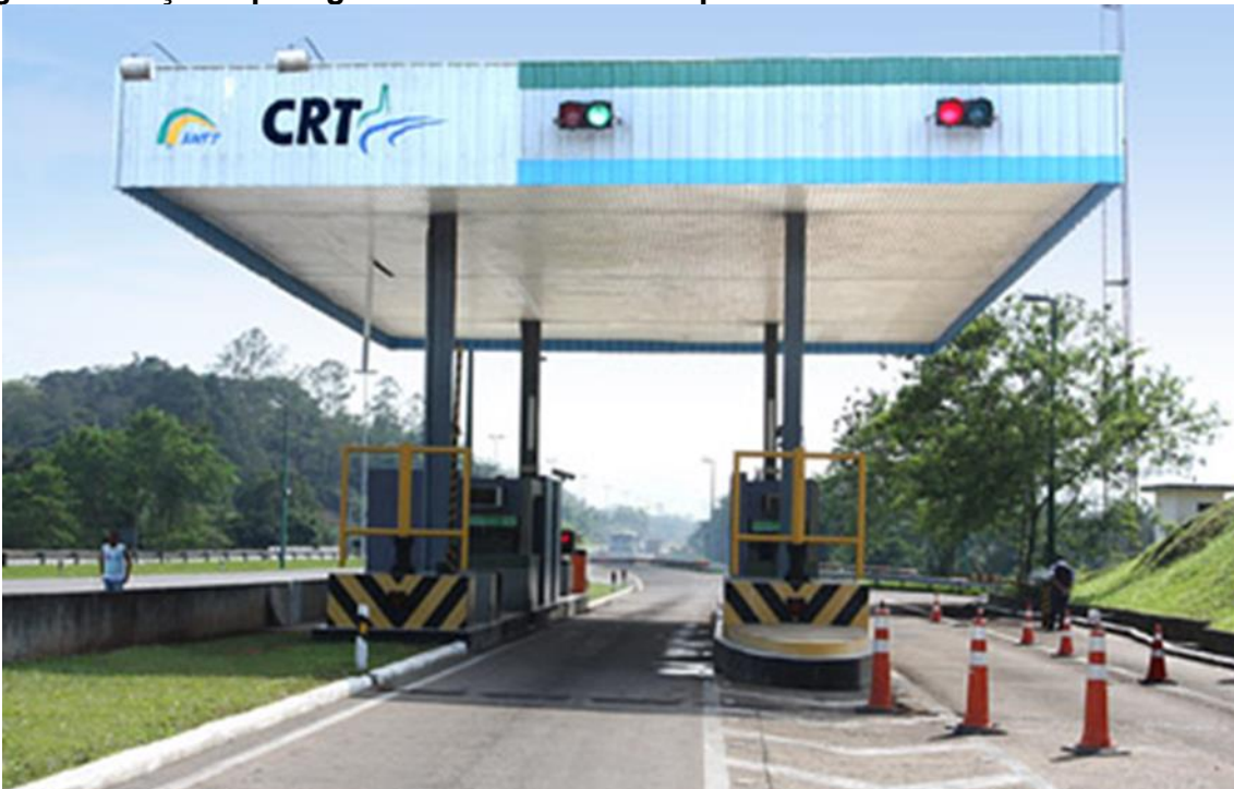
Figura 6: Praça do pedágio rodovia Rio – Teresópolis.
