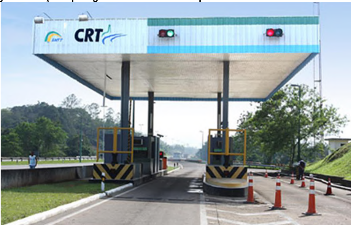
Figura 6: Praça do pedágio rodovia Rio – Teresópolis.
