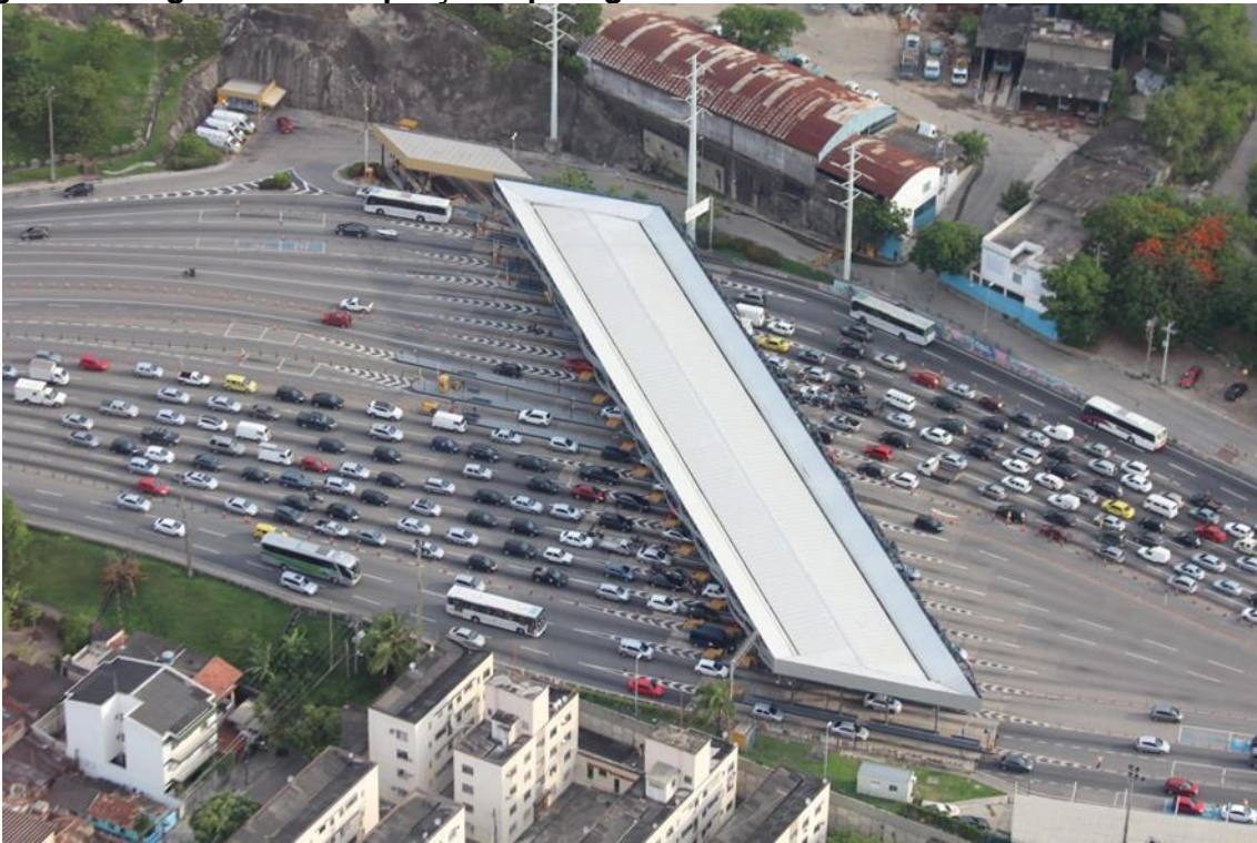
Figura 5: Imagem aérea da praça do pedágio da linha amarela – Lamsa.
