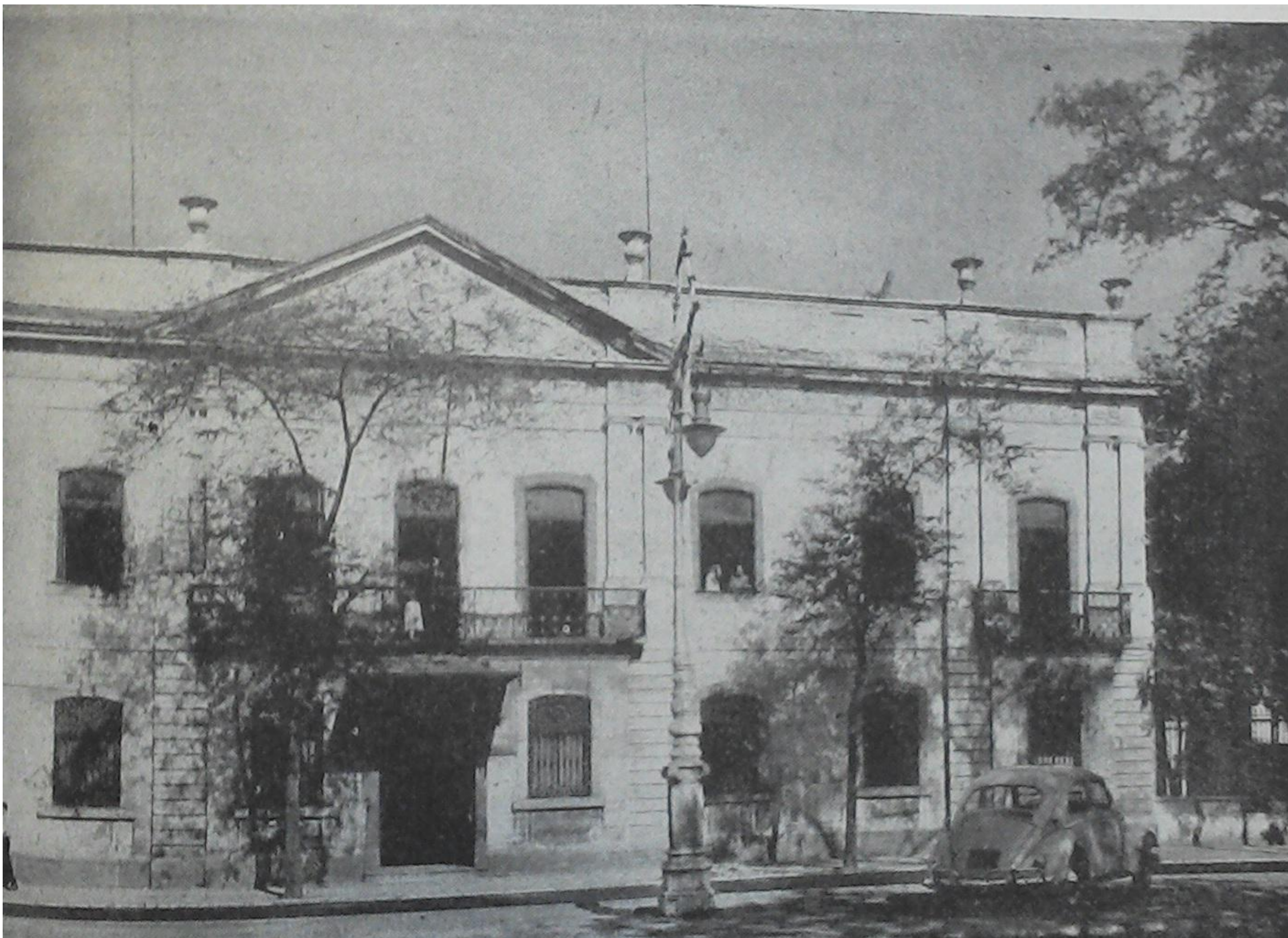
Fig 1. Restauração do Palácio da Marquesa de Santos, Rio de Janeiro-RJ, data?, projeto de Wladimir Alves de Souza e Geraldo Câmara. Fonte: Revista Arquitetura (IAB), nº 56, 1967, p. 23
