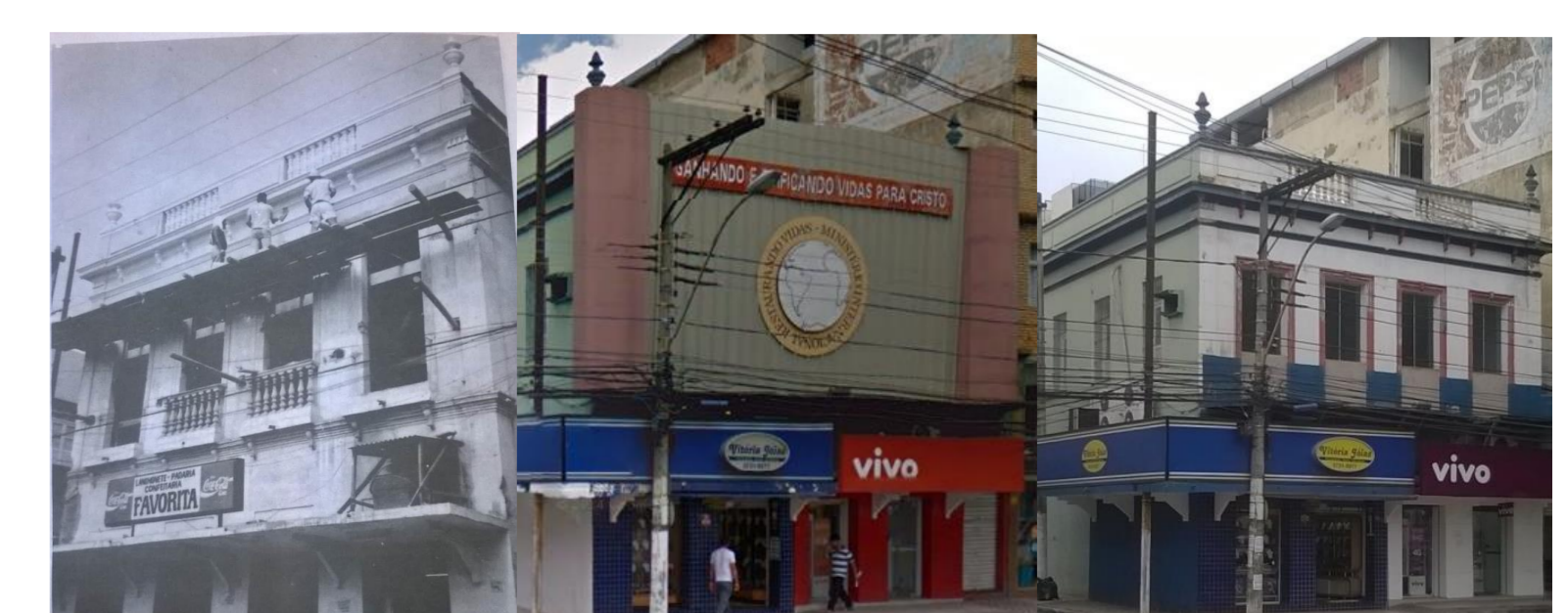
Figuras, 11, 12 e 13: Sobrado à Avenida Getúlio Vargas nº 396, em 1988, durante obras, em 2013 e em 2015. Fonte: Revista Nossa. / Google Street View / Acervo pessoal
