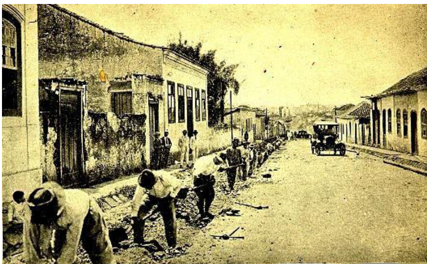
Figura 10 – Obra de assentamento da rede de esgotos da cidade de Cachoeira do Sul, cujo projeto de saneamento é de autoria do engenheiro Saturnino de Brito (SOP, Relatório de 1924, 2v. s/p.).
