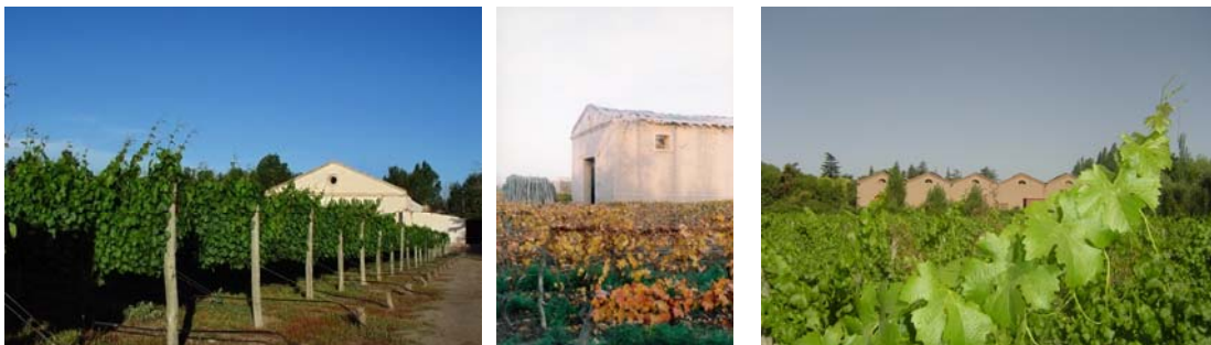
MENDOZA. Las bodegas de principios del siglo XX se construyeron en mampostería de adobe o ladrillo a la vista. Los volúmenes eran aislados o yuxtapuestos según las necesidades de cada establecimiento. Izquierda: Bodega Alto Cedro en Valle de Uco. (Karim Mussi, 2005). Centro: Bodega en Lunlunta. Derecha: Bodega Benegas en Luján de Cuyo. (Elena Moretti, 2007)
