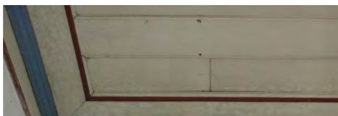
Figura 8 – Forro Saia e Camisa da Casa Sede da Fazenda Fortaleza
