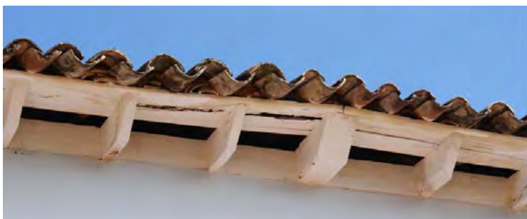
Figura 7 – Beiral em Cachorrada da Casa Sede da Fazenda Fortaleza
