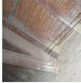
Destacamos que se pueden encontrar en estas cabriadas de madera diagonales que unen el cordón inferior de las cabriadas a los muros. Estos elementos son agregados a la estructura para aliviar los esfuerzos a los que son sometidos los cordones inferiores, cuando la sección que poseen no alcanza para soportar el peso en conjunción a la luz que cubre. Como podemos observar en la bodega sin identificar de calle Serpa 6195 de Rodeo del Medio, Maipú.
