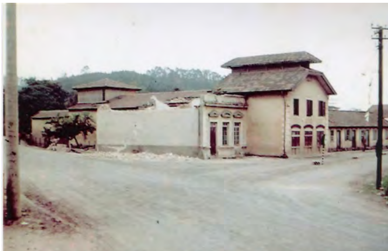
Figura 5: O edifício do cinema em processo de demolição. Fonte: Acervo Paulo Polkorny, [s.d].
