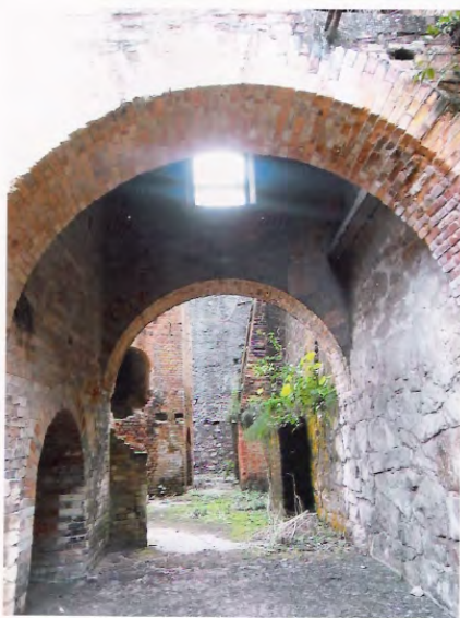
Figuras 9: Detalhe do forno de cal Fonte: Acervo da autora, 2005.
