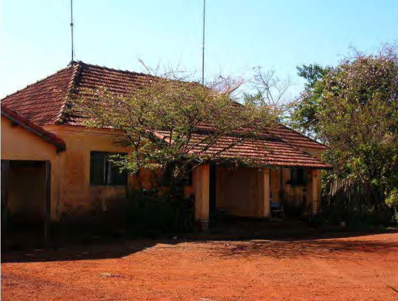
Figura 5: Casa de colônia atual, ao lado da igreja. Teve as janelas originais trocadas por metálicas e foram construídos alpendre e garagem.
