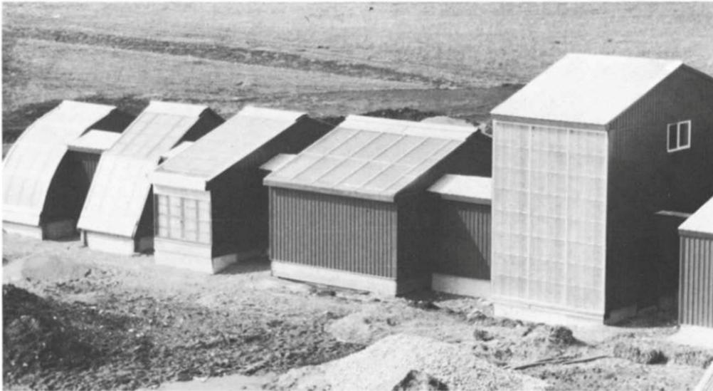
Figura 61: Cinco modelos de casa com painéis fotovoltaicos posicionados em locais diferentes.
