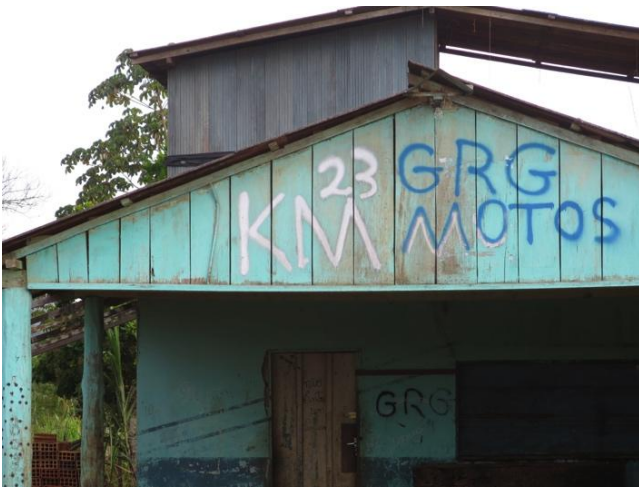
Figura 4- Identificação em edifício diante da rodovia Transamazônica na agrovila do Km 23. Fonte: O autor, 2015.
