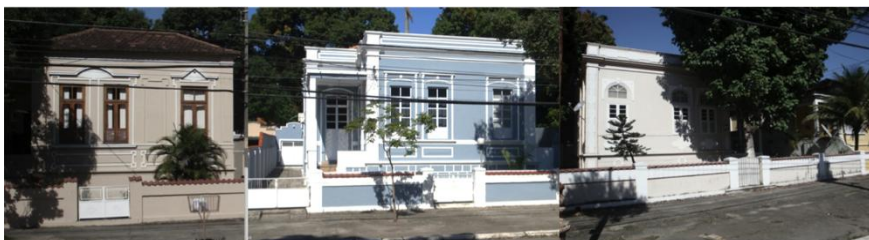
Figura 9 – Diferentes formas de telhados e elementos estéticos das fachadas de três casas vizinhas, situadas nos lotes no meio de uma quadra na Av. Duque de Caxias. Reparar a mesma configuração volumétrica e relação de cheios e vazios com as esquadrias, o que pode ser interpretado como pertencentes ao tipo 01. Outra importante observação se deve à forma de implantação variada, de modo que as duas à esquerda se repetem, mas a implantação à direita é espelhada em relação às outras duas, marcando mais uma estratégia de variação. Fonte: foto da autora (2012).
