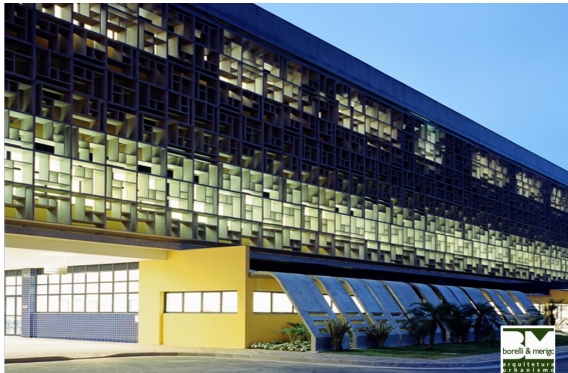
Figura 1: Perspectiva da fachada Oeste, fornecido pelo arquiteto José Borelli.
