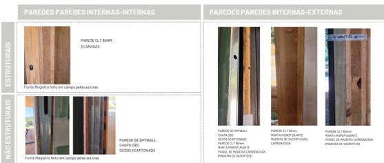
Figura 03 - Compilação de soluções técnicas do uso do CLT no sistema de paredes
