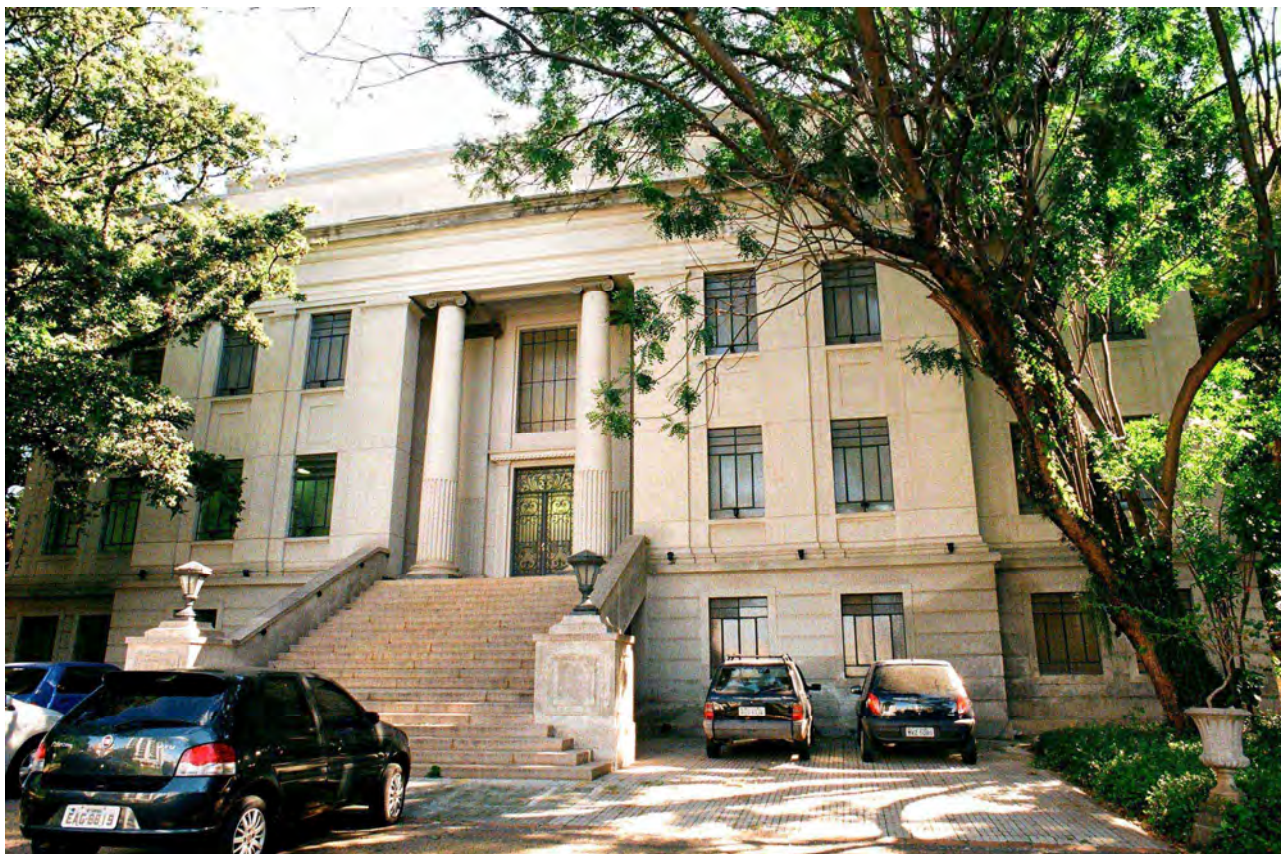
Foto 2 (01/06/2010) - Fachada frontal do Edifício Franz W. Dafert após intervenção de restauro.
