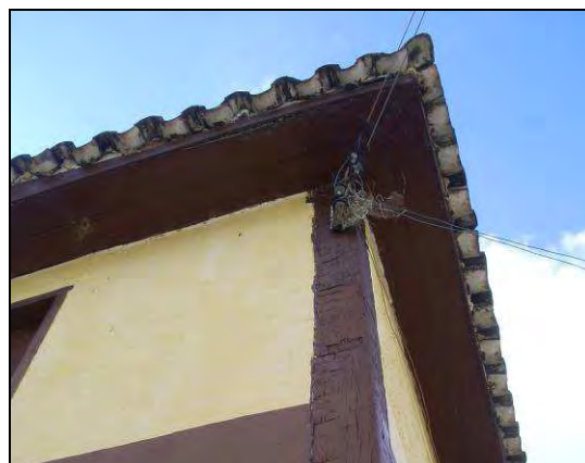
Figura 31 - Beiral, Casarão do Sr. Braulino Bidu. Alvenaria de tijolos, 2009.
