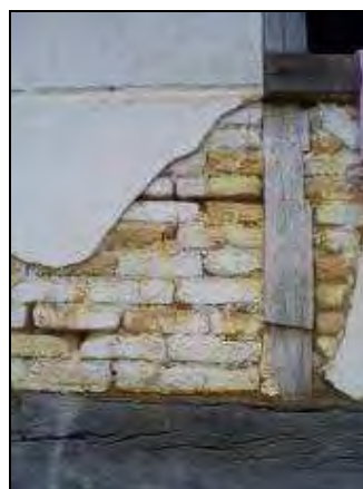
Figura 27 - Fazenda Santa Bárbara, detalhe da parede em tijolos, 2009.
