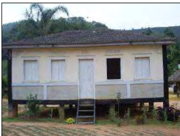
Figura 33 - Casarão do Sr. Cláudio Moreno. Data de construção e localização na fachada frontal, 2009.
