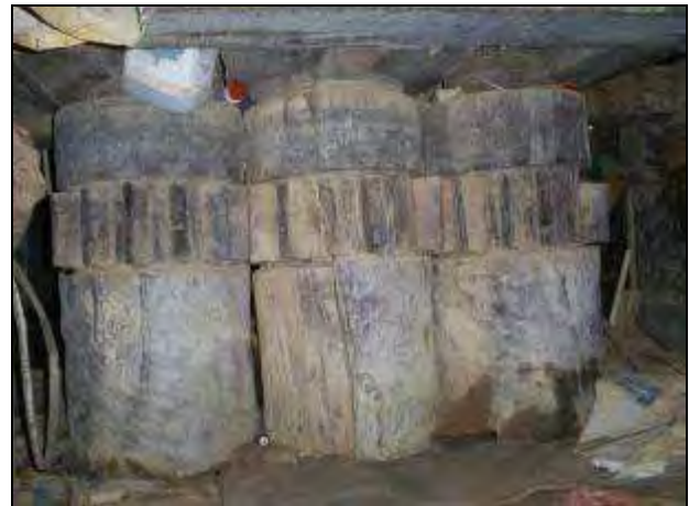
Figura 21 – Detalhe das engrenagens, 2009.
