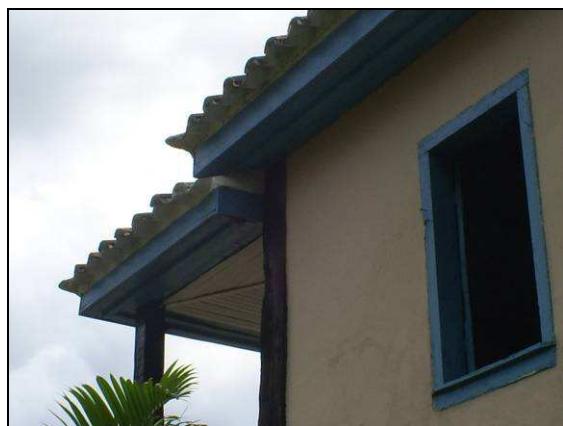
Figura 30 – Beiral, Casarão do Sr. Hélio Gringa. Alvenaria de pau-a-pique, 2008.
