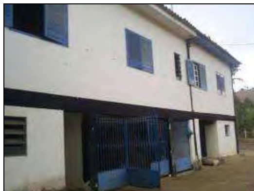
Figura 38 – Casarão da Fazenda Boa Esperança. Construção de parte da casa em concreto, 2009.
