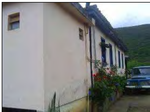
Figura 37 – Casarão do Sr. Maninho Barba. Tubulações e anexo, 2009.
