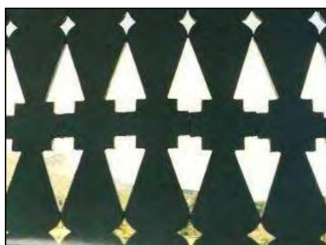
Figura 36 – Detalhe do alpendre do Casarão do Sr. Hélio Gringa, 2008.
