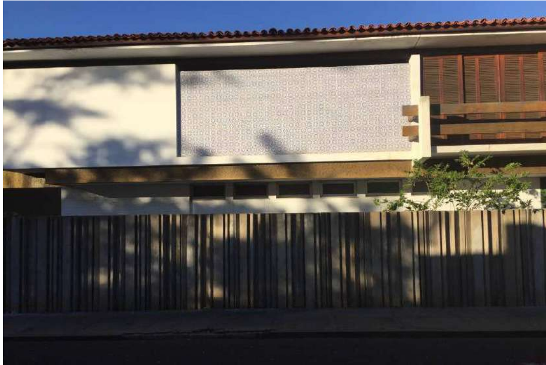
Imagem 4: Detalhe da residência de Mansueto Martins Magalhães – 1968, uma das mais bem conservadas obras de Antônio Luiz. É possível identificar o uso de concreto, azulejos pintados, madeira, telhas cerâmicas e muro formado de tábuas de concreto cravadas no piso. Fonte: Aline Lira, 2016.
