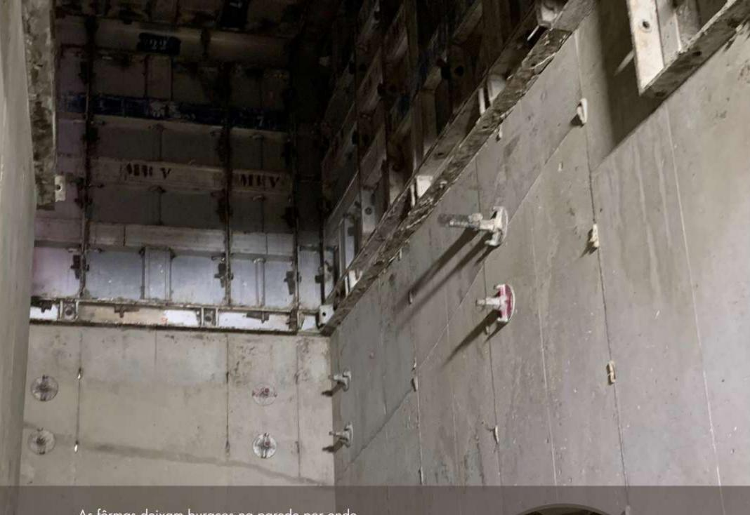
As fôrmas deixam buracos na parede por onde passam elementos fixadores, portanto, é necessário preenchê-los. Durante a visita, foi comentada a possibilidade de alteração nas fôrmas em obras futuras por conta da posição das faquetas (ou espaçadores): A considerável distância entre elas dificultava seu preenchimento durante a obra. Desse modo, após a remoção das fôrmas, as paredes necessitam de um acabamento para serem amenizadas essas marcas.
