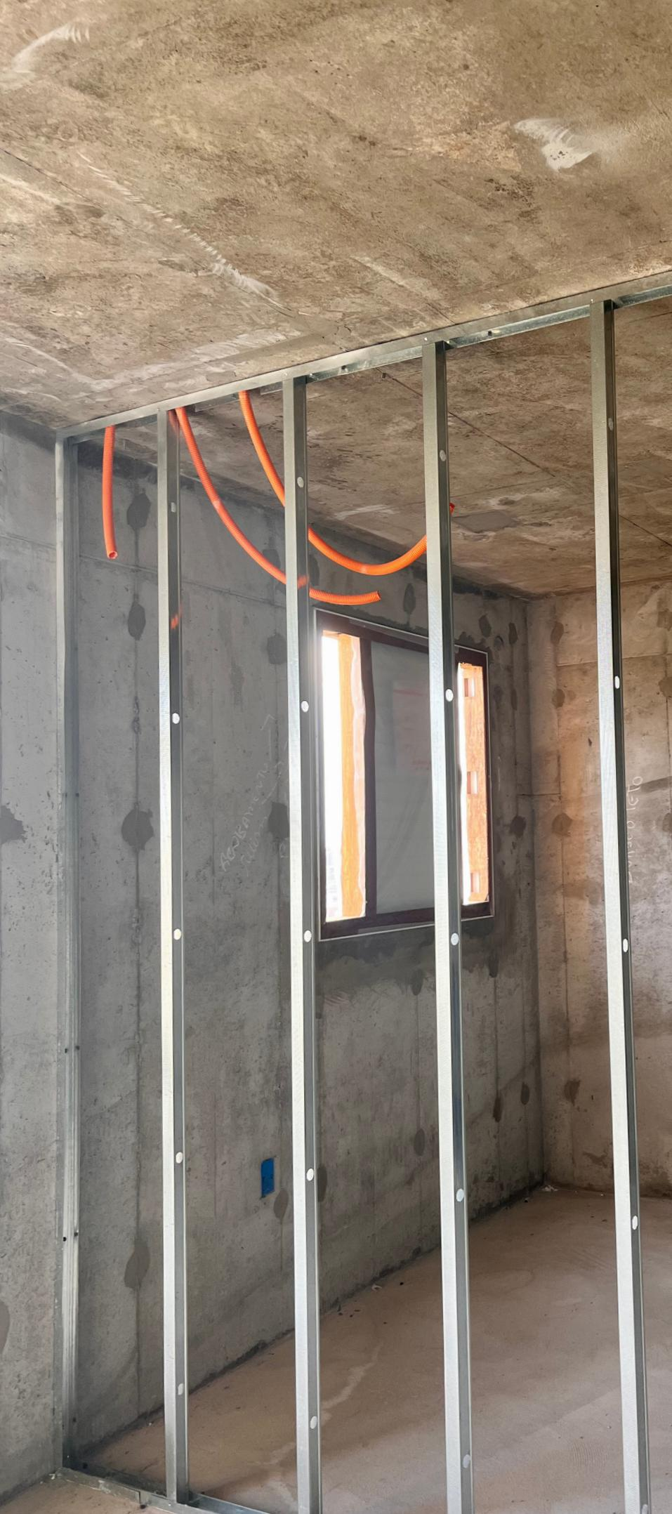
Nessa etapa, ocorre a instalação dos frames de aço (com perfil de 90mm e espaçadas a cada 50cm) que atuam dando estrutura para as paredes de dry wall as quais serão, posteriormente, alocadas. Essas últimas funcionam como divisórias de cada apartamento, separando os ambientes internos.
